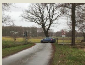
Alpebrücke Pottstraße Rodewald
